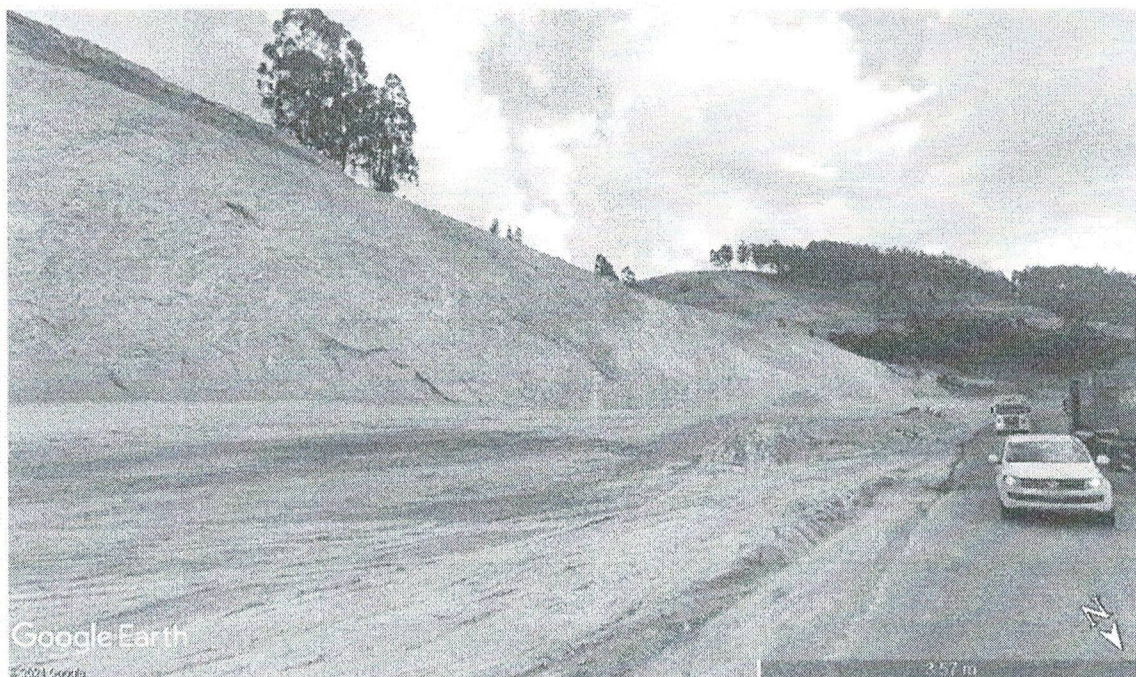
Figura 4 - Talude de corte à margem da BR-482 (Imagem do Google Earth, atualização em agosto/2024).
