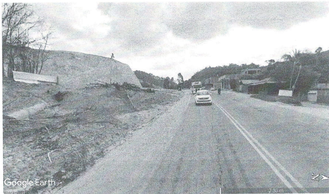
Figura 2 - Vista do ponto inicial dos taludes de corte, à margem da BR-482 (Imagem do Google Earth, atualização em agosto/2024).
